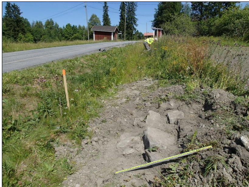
Koekuoppa 9. Kuoppa kaivettiin maanpinnalle näkyvien kivien kohdalla. Kivien päältä ja lomasta todettiin tiilen paloja, laastia sekä betonirautaa. Pohjoiseen.
