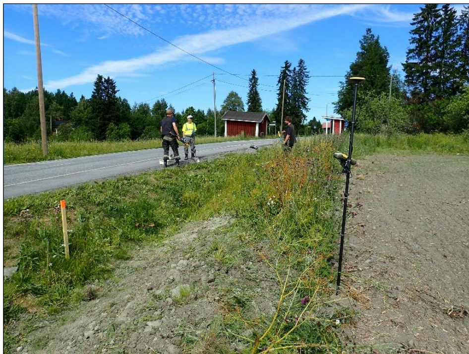
Kuvassa vasemmalta Juuso Koskinen, Hannu Poutiainen ja Timo Sepänmaa. Koekaivetun kaapelireitin keskiosaa. Vasemmassa laidassa näkyvä puupaalu ei ole kaapelireitillä – suunniteltu reitti kulkee ojan ja pellon välisessä penkassa, noin puoli metriä RTK GPS -laitteesta vasemmalla. Pohjoiseen
